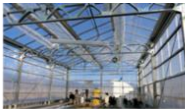
日射を取入れた明るい温室
