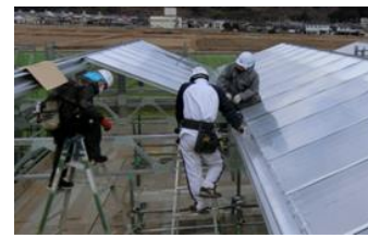
統合化VE工事工法
