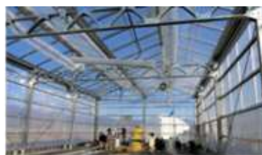
日射を取入れた明るい温室
