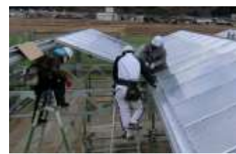
統合化VE工事工法
